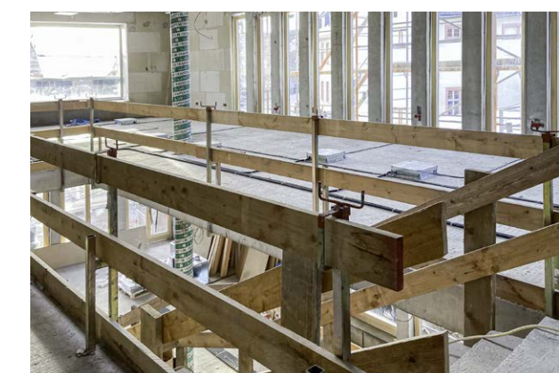
Blick nach innen: Auch drinnen schreien die Arbeiten zügig voran.
